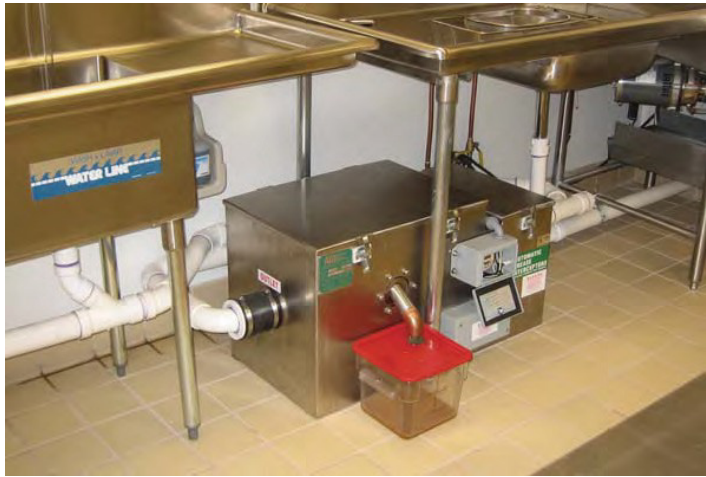
圖4. 安裝的自動食油清除設備示範。資料來源：廢水解決方案最新資訊
