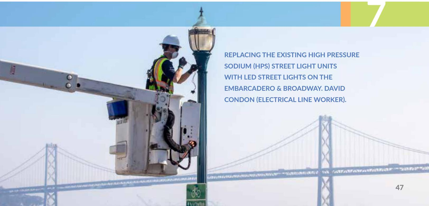
REPLACING THE EXISTING HIGH PRESSURE SODIUM (HPS) STREET LIGHT UNITS WITH LED STREET LIGHTS ON THE EMBARCADERO & BROADWAY. DAVID CONDON (ELECTRICAL LINE WORKER).
